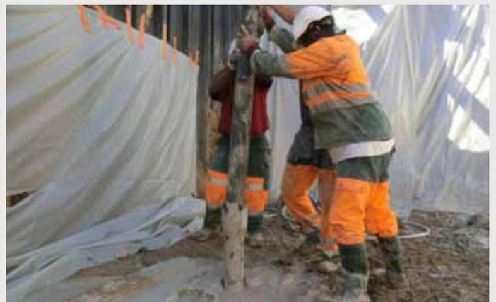
**i** Maître d'ouvrage ALATAREA-COGEDIM, France +++ Maître d'œuvre ESOA Lognes 77, France +++ Entreprise GEOSYS (Groupe SEGEX), France +++ Ouvrage Pieux fichés dans les alluvions à 10m sous le TN et fonctionnant en tirants-radier (poussée hydrostatique, trémies)
