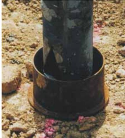
Les pieux battus enrobés, installés par battage et injection simultanés, peuvent être utilisés dans des contextes géotechniques pour lesquels d'autres systèmes sont inappropriés, avec par exemple : présence d'une nappe phréatique ou de sols contaminés.
